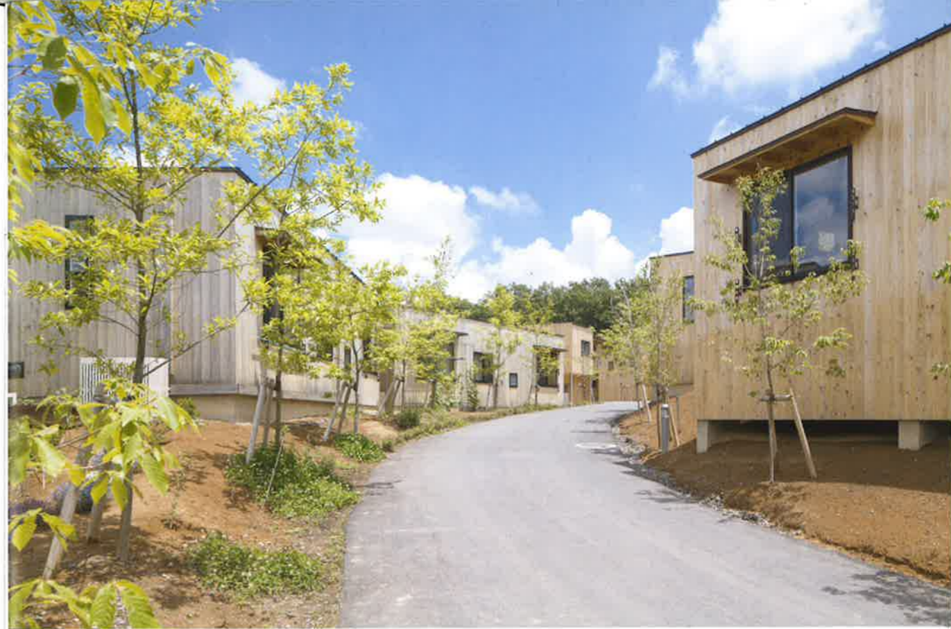
C棟とD棟の間の広小路
